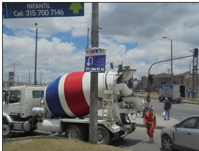
FOTO 2. Elementos instalados en Espacio Público Ubicados en La Localidad de Fontibón y Kennedy. Operativo del 29-08-2015.
